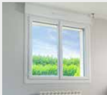
La nouvelle menuiserie est installée sans dégradation
