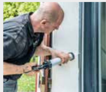
Pose des joints de finitions
