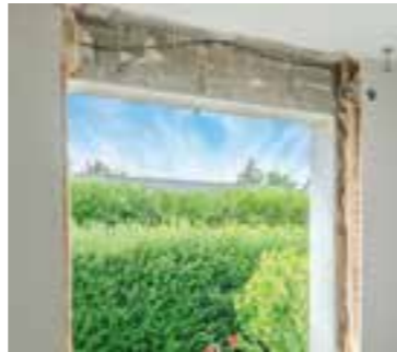
Vérification de la propreté des supports
