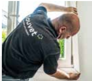
Pose des ailes de recouvrement
