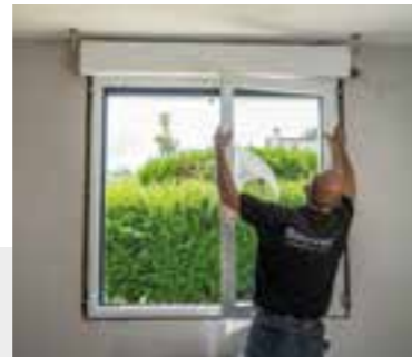
Mise en place des ouvrants
