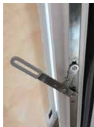
Verrou toute hauteur Pour déverrouillage semi-fixe en 2 vantaux
